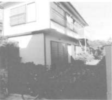
(仮称)いたる第11ホーム外観
