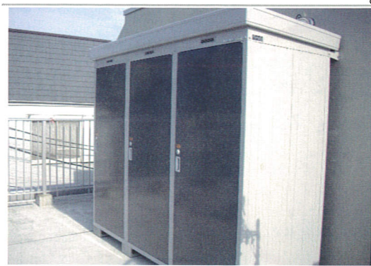
グループホームの防災拠点、ワルツの屋上に新設した防災倉庫。
